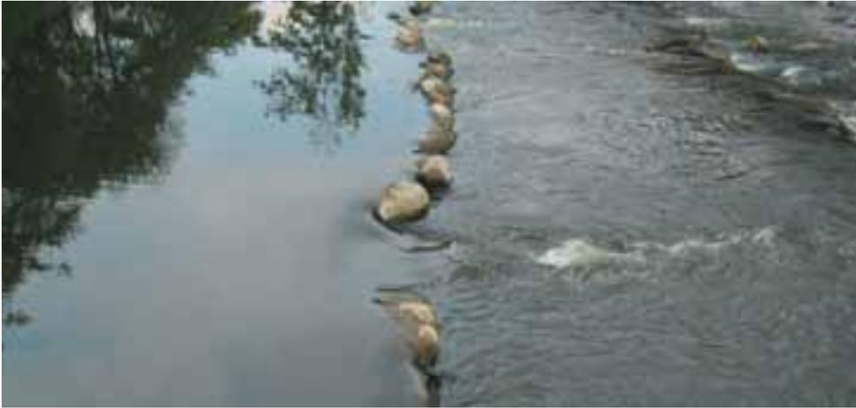
Foto 11: Ausschnitt aus einer Sohlgleite in Riegelbauweise, bei der kein Übergang zwischen dem rückgestauten Bereich oberstrom (mit Stillwasserbedingungen) und dem obersten, durchgehenden Querriegel besteht. Bei diesem Beispiel musste allerdings die Aufstauung aufgrund der örtlichen Rahmenbedingungen gehalten werden.
