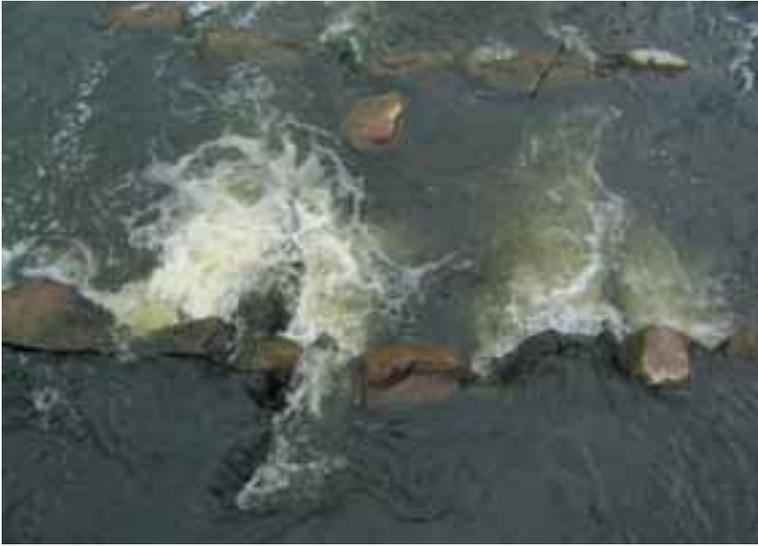
Foto 8: Starke Turbulenzen in dem Beckenbereich unterstrom eines durchgehenden Querriegels einer Sohlgleite in Riegelbauweise. Die Ursache liegt in einer hohen Wasserspiegeldifferenz und in dem Flaschenhalseffekt der Lücken zwischen Riegelblöcken. Die Turbulenzen verkleinern die Ruhebereiche in den Becken, erschweren die Orientierung von Fischen sowie die Passierbarkeit der Lücken.
