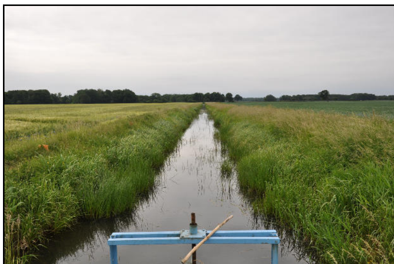
Abbildung 73: Eingestauter Quitzöbler Abzugsgraben bei stat. km 01+800 (Foto: FPB GmbH, 31.05.2012)
