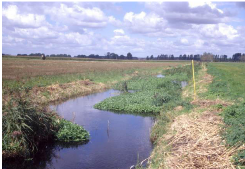
Abbildung 88: Beispiel für wechselseitige Sohlkrautung. Quelle: DWA-M 610 (2010), S. 95.
