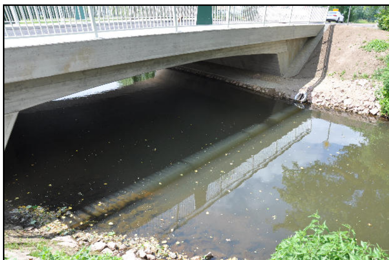
Abbildung 78: Regenwassereinleitung an der neugebauten Straßenbrücke am Ortseingang Bad Wilsnack bei km stat. 16+800 (Foto: FPB GmbH, 30.05.2012)
