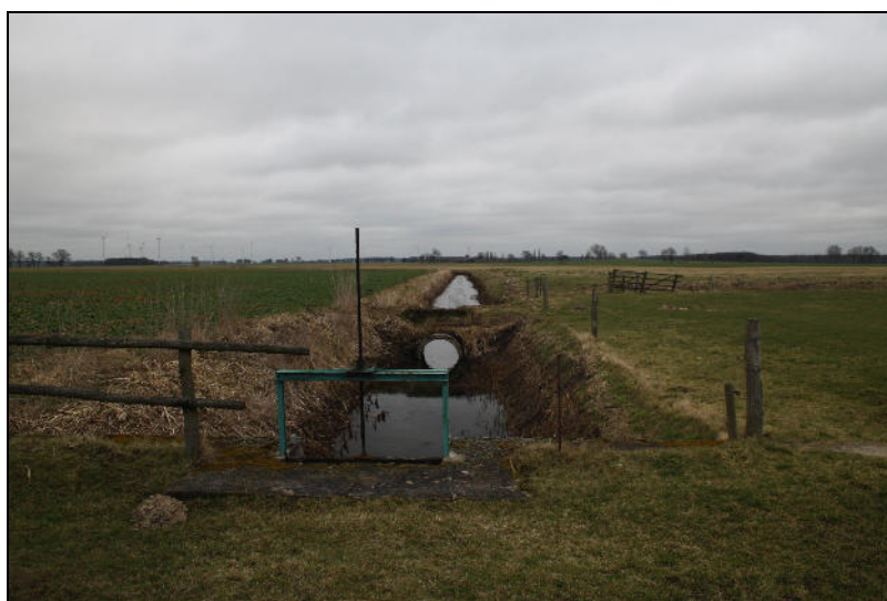
Abbildung 77: Nicht durchgängiger Fließgewässerabschnitt des Söllenthingrabens bei km stat. 00+900 (Foto: FuK, 12.03.2012)
