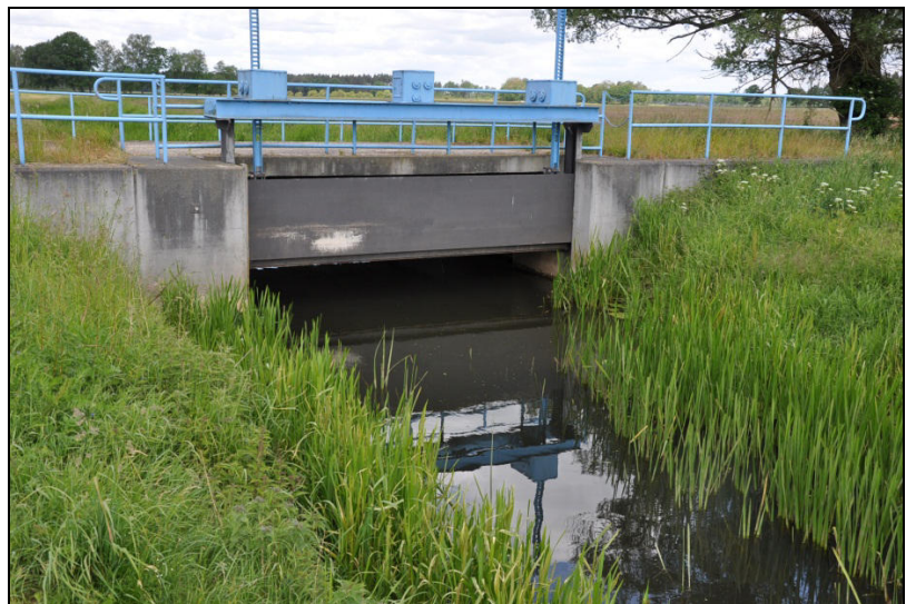
Abbildung 14: Querbauwerk (Schützwehr) am Cederbach (Foto: FPB 2012)
