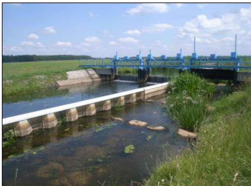
Abbildung 55: Wehr im Unterlauf der Karthane (km 8). Foto: DHI-WASY 04.07.2012.
