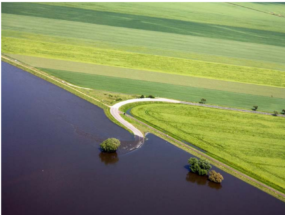
Abbildung 2.10: Eine Landstraße und Ackerflächen versinken im Juni 2013 in den Fluten. An der deutschen Verkehrsinfrastruktur und im Agrarbereich entstanden durch das Hochwasser große Schäden. (Quelle: LHW)
