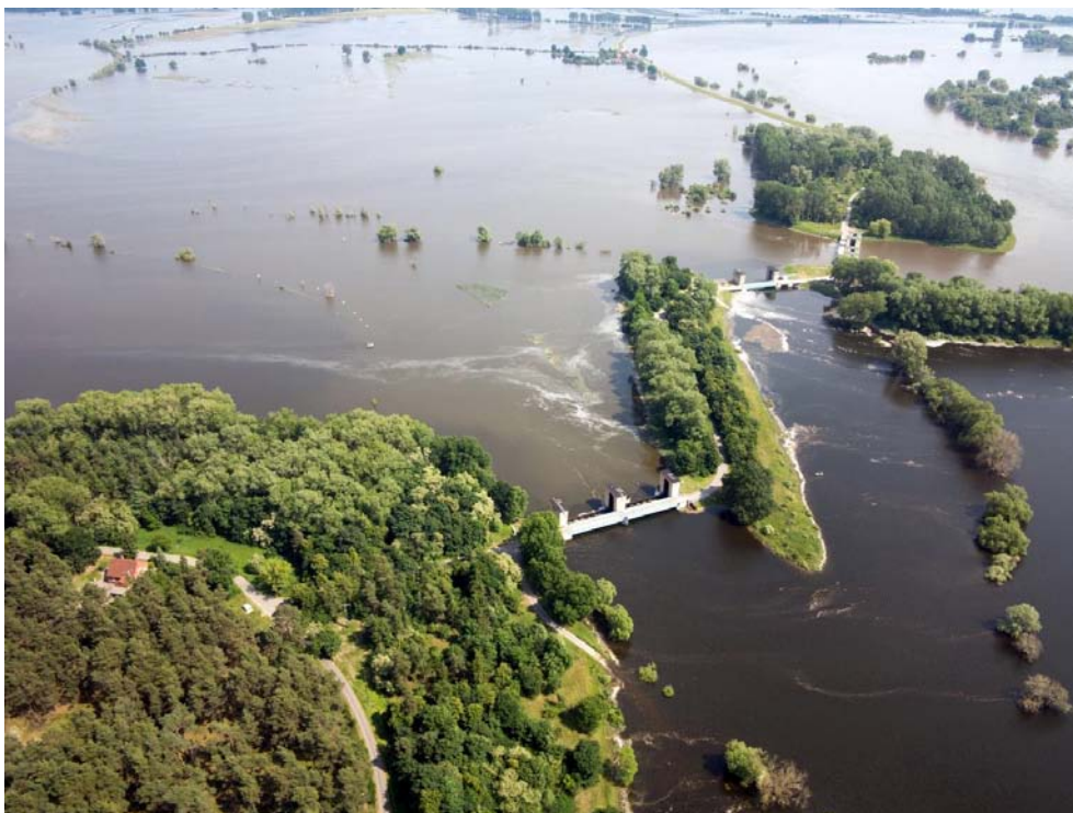
Abbildung 4.2: Wehranlage Quitzöbel an der Landesgrenze zwischen Sachsen-Anhalt und Brandenburg zum Hochwasser 2013 (Quelle: LHW)
