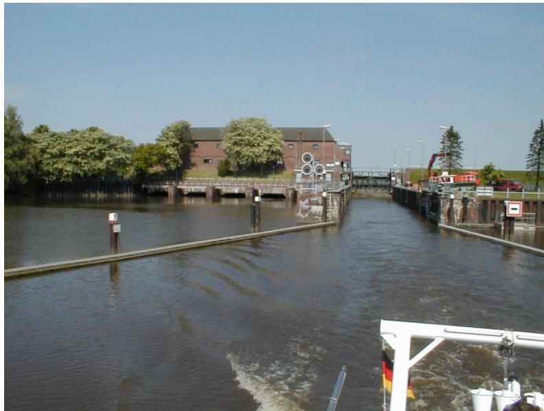
Abb. 10: Eider, Schleuse bei Nordfeld
