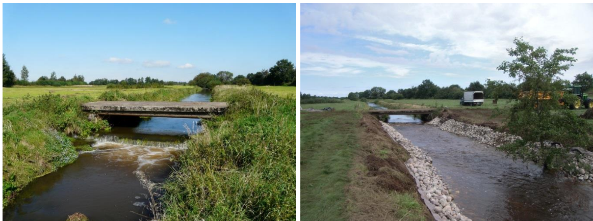
Abb. 76: Jerrisbek vor (2009) und nach (2010) Bau einer Sohlgleite
