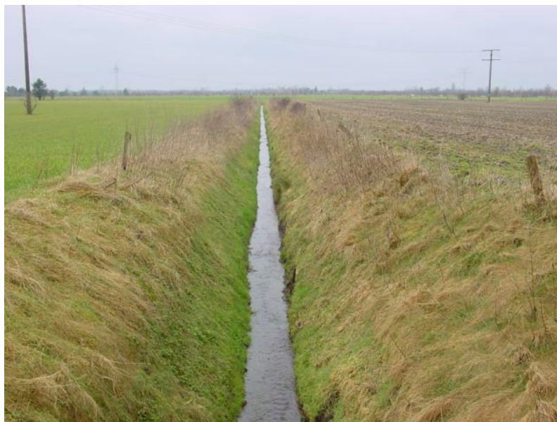
Abb. 11: Begradigtes und querschnittsverändertes Gewässer
