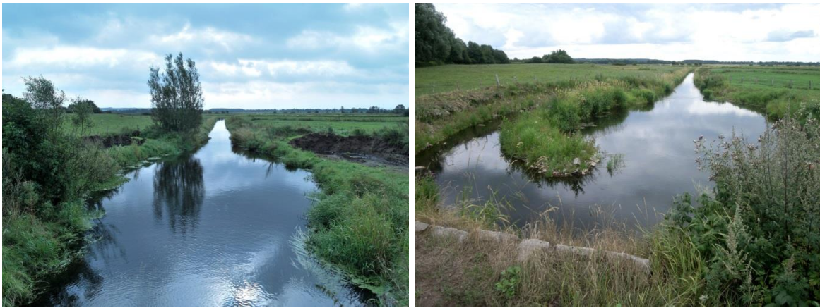
Abb. 77: Mühlenbach vor (2009) und nach (2010) Bau eines Sandfangs
