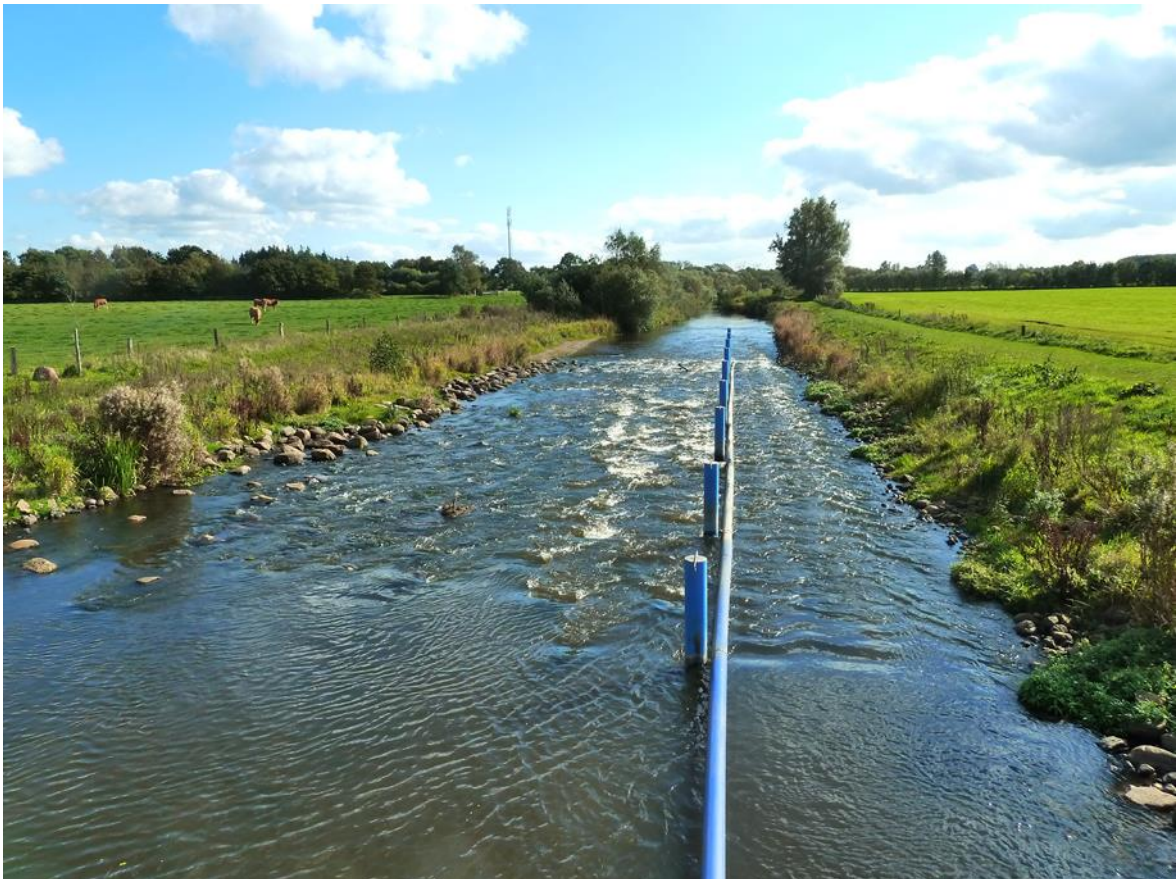
Abb. 9: Beispiele für die Verbesserung der linearen Durchgängigkeit in der FGE Eider (Sohlgleite bei Treia)
