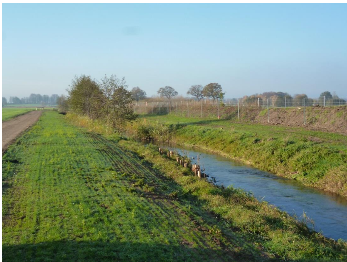
Abb. 83: Frisch angelegter, beidseitiger Gewässerrandstreifen im November 2013
