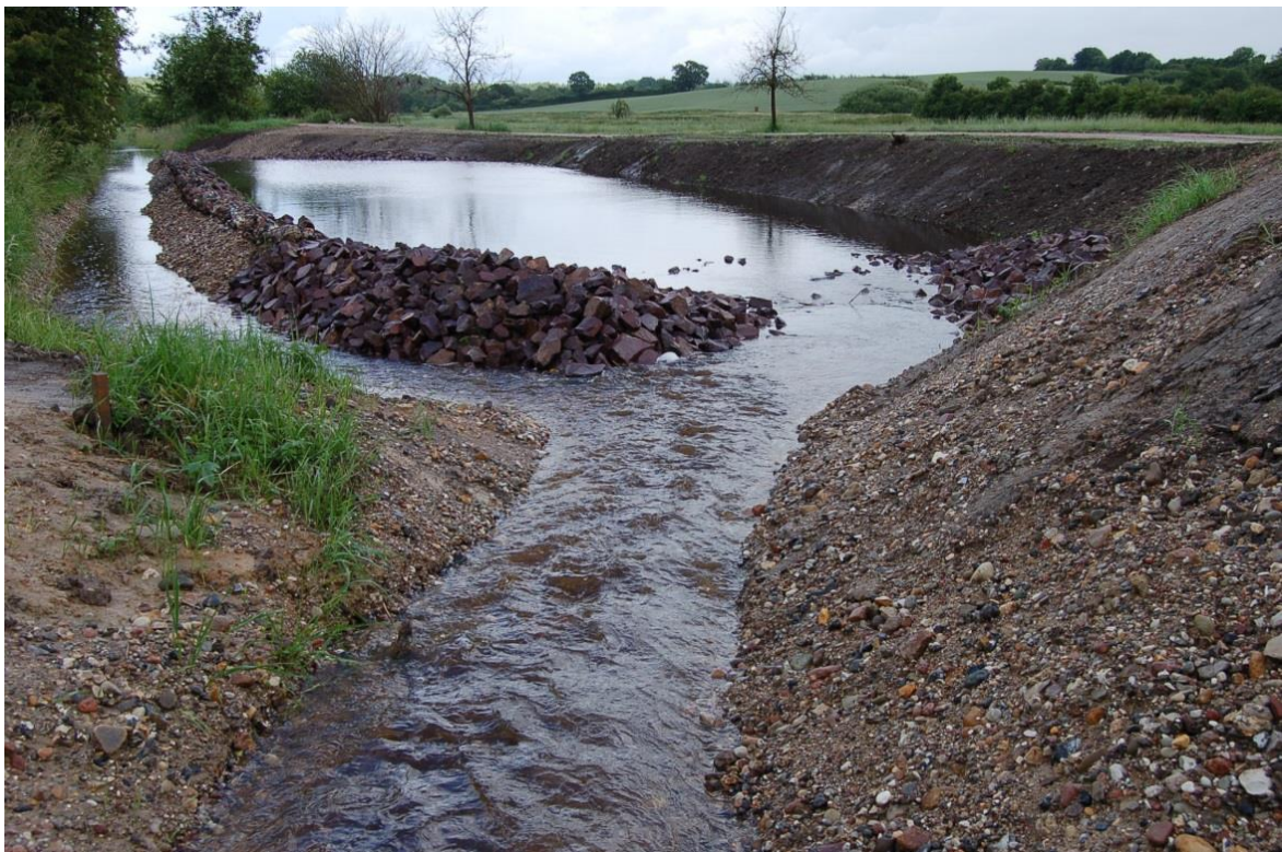
Abb. 86: Sandfang mit Bypass
