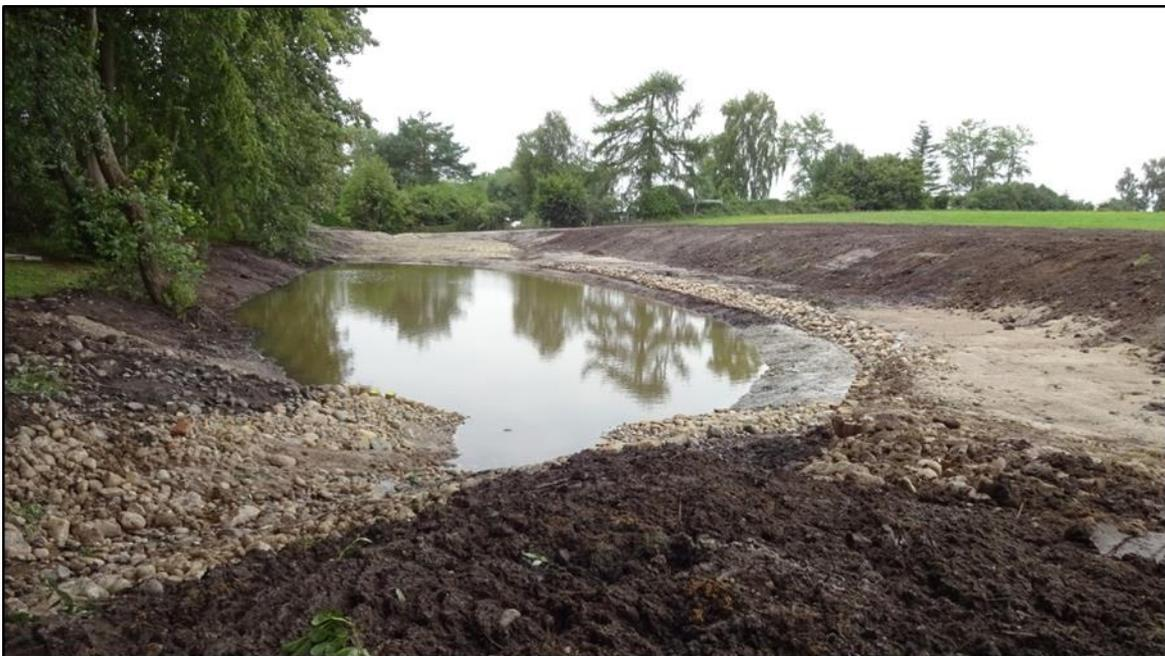
Abb. 21: Sedimentationsbecken an einem Zulauf des Selenter Sees (Foto: A. König)
