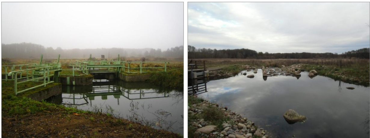
Abbildung 5-2: Beispiel für ein umgebautes Querbauwerk in M-V: vor der Maßnahme Verteilerbauwerk mit zwei Wehren und nach dem Umbau mit FAA-Umgehungsgerinne (Fotos: H. Schneider, StALU Mittleres Mecklenburg)
