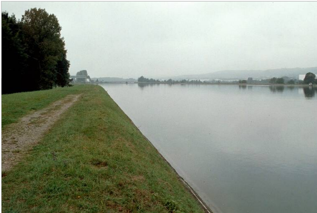
Seitendamm des Oberrheins bei Kehl (Quelle: BfG)
