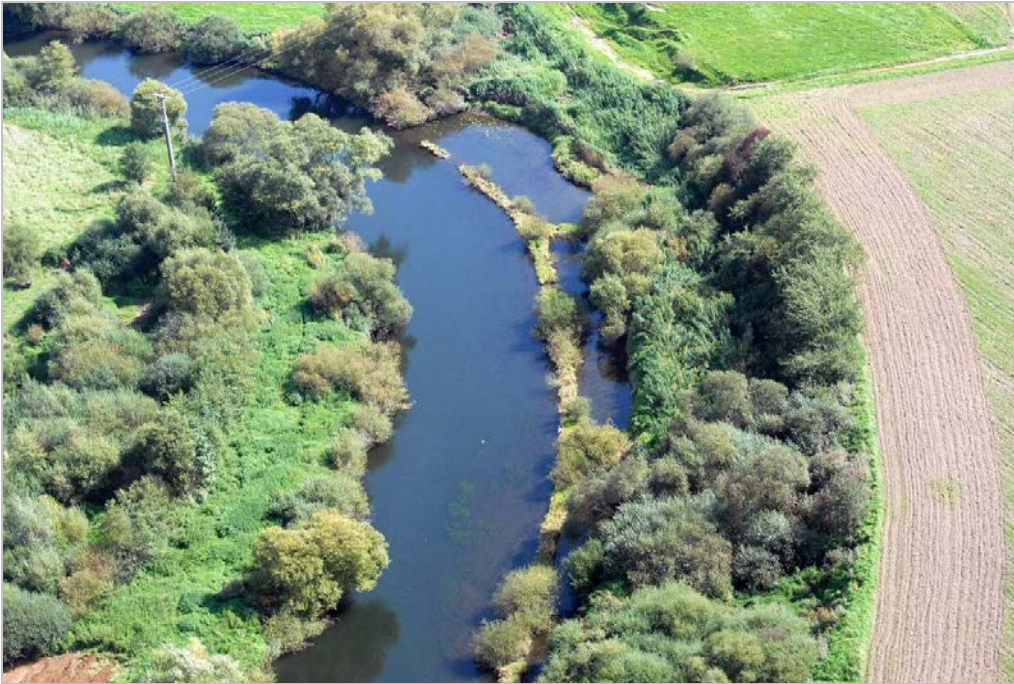
Leitwerk mit Stillwasserbereichen an der Lahn bei Neu-Selters (Quelle: BfG)
