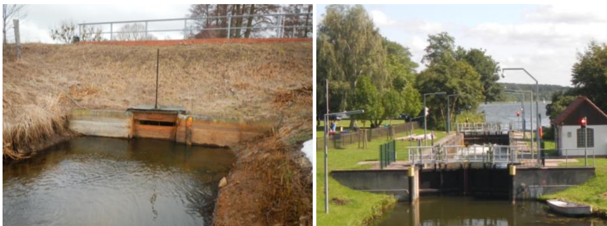
Abbildung 8: Für Fische und Wirbellose nicht durchgängiges Wehr am Straßendurchlass Ahrensdorfer Kanal (links) und nicht durchgängige Schleuse Himmelpfort (rechts). (PÖYRY 2015)
