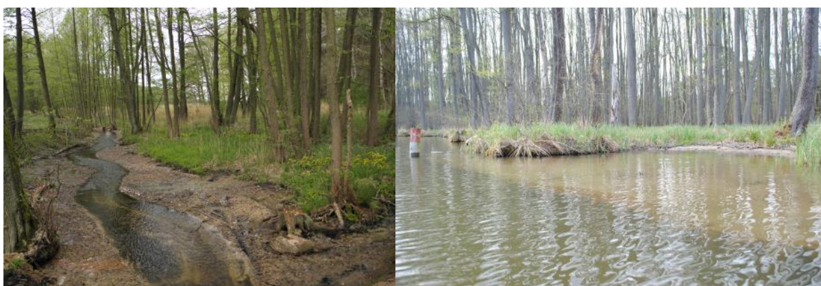
Abbildung 13: Beispiel für eine naturnahe Sohlgleite (Faules Fließ bei Kappe kurz nach Fertigstellung, links). Beginn einer natürlichen Uferzonierung an der Woblitz (rechts).
