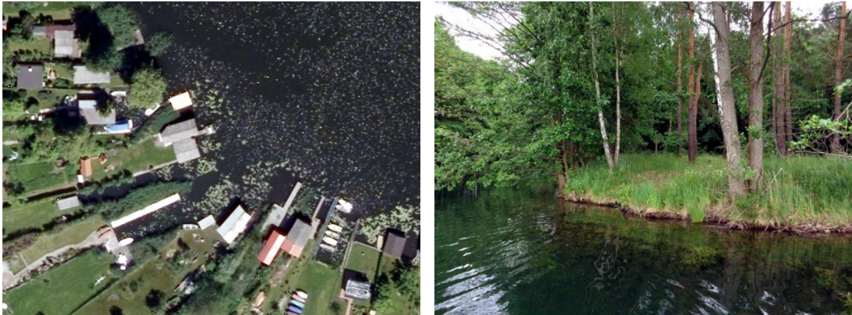
Abbildung 63: Reliefändernde Objekte im Sub- und Eulitoral. Links – Mosaik von Abgrabungen und Aufschüttungen privater Uferparzellen am Baalensee. Rechts – Aufschüttung des Aushubs (rechts) mit Austiefung am Einlauf (links) des ehemaligen AKW-Kühlwasserkanals im Nehmitzsee (Foto: W. Ostendorf, 14.06.2014).
