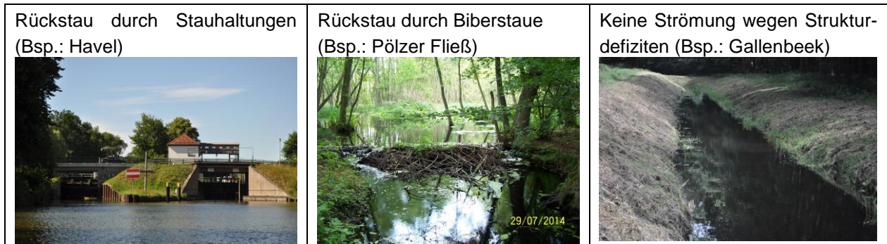
Abbildung 45: Ursachen für defizitäre Fließgeschwindigkeiten im GEK OH 1a, beispielhaft gezeigt anhand von vor-Ort Aufnahmen
