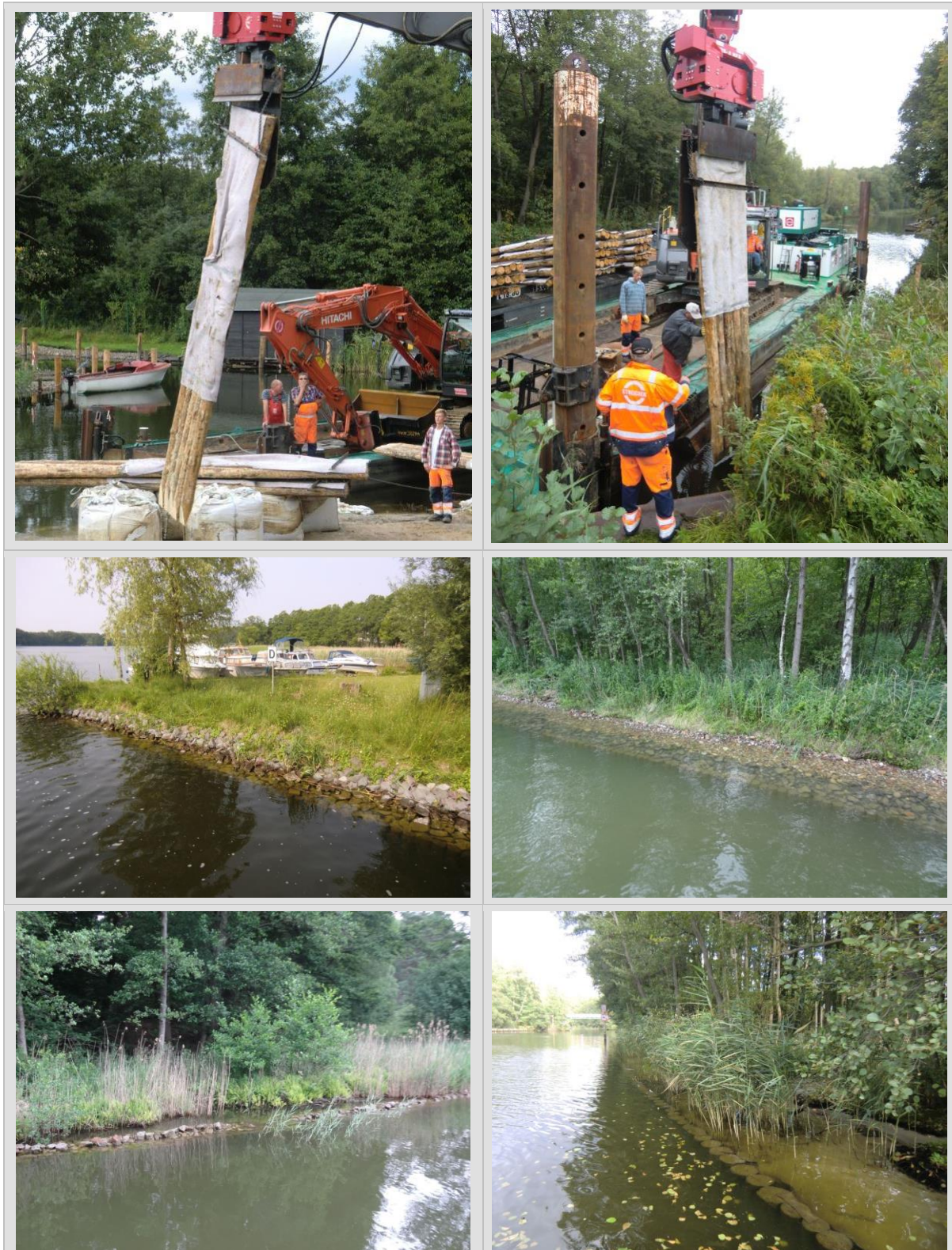
Abbildung 12: Einbauvarianten von Pfahlpaketen im GEK Rhin 1 und 2
