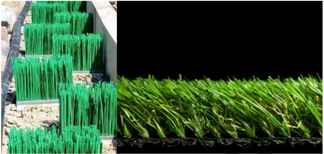
Abbildung 15: Bsp.: für Kunstrasen und Borstenfischpasseinbauten
