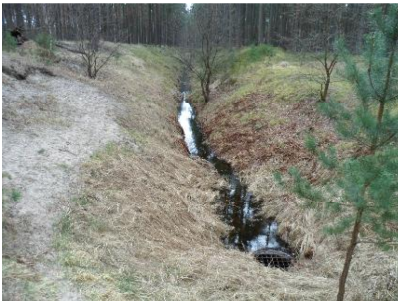
Abbildung 6: Einlaufschacht im Lotzingraben bei Stat. 8385,5
