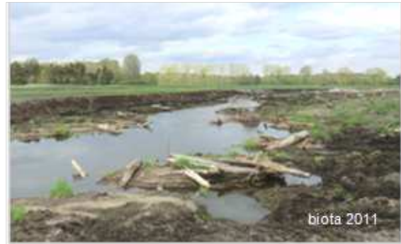
Abbildung 19: Einbau von Totholz
