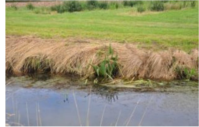
Ablage des Mähgutes im Gewässerprofil – teilweise durch vorherige Arbeiten der Anlieger
