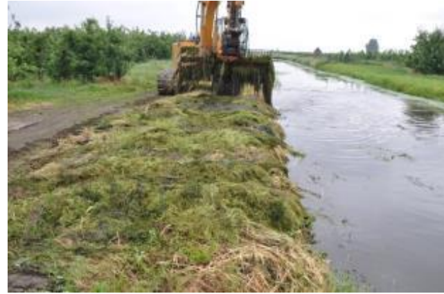
Ablage des Mähgutes im Gewässerprofil – teilweise durch vorherige Arbeiten der Anlieger
