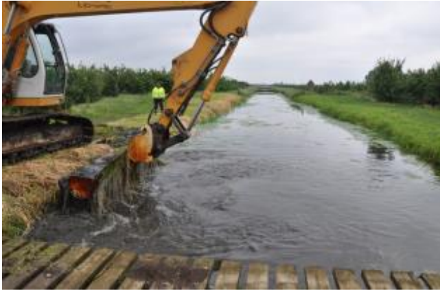
¾ Sohlmahd und Bearbeitung des Böschungsfußes
