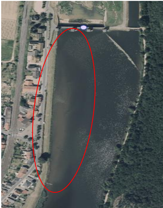
Abbildung 4.10: Stauraum im Oberwasser mit markierter Sedimentablagerung
