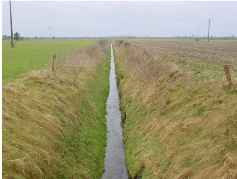
Abb. 10: Begradigtes und querschnittsverändertes Gewässer
