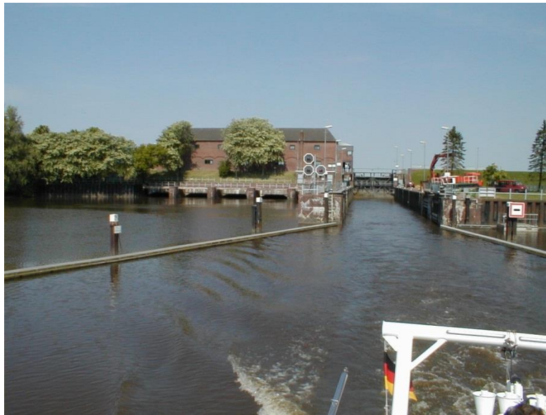
Abb. 9: Eider, Schleuse bei Nordfeld
