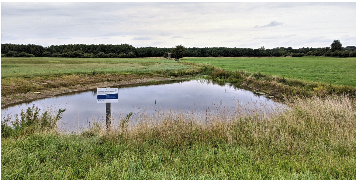
Abb. 5: Dränteich zwei Jahre nach Fertigstellung (Foto: LKN.SH, Yvonne Herrmann)
