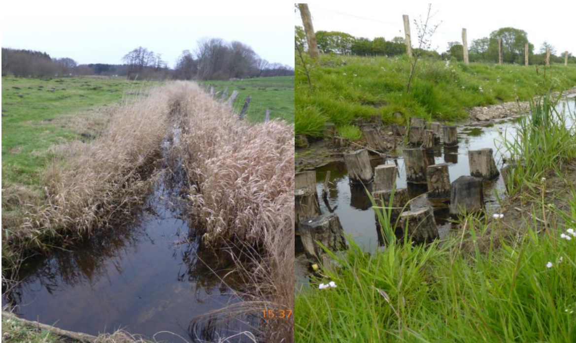
Abb. 10: links: Gewässerabschnitt vor der Umgestaltung (Foto: UWB RD, Fr. Achilles), rechts: Strömunglenkende Pfahlbuhnen (Foto: UWB RD, Fr. Achilles)
