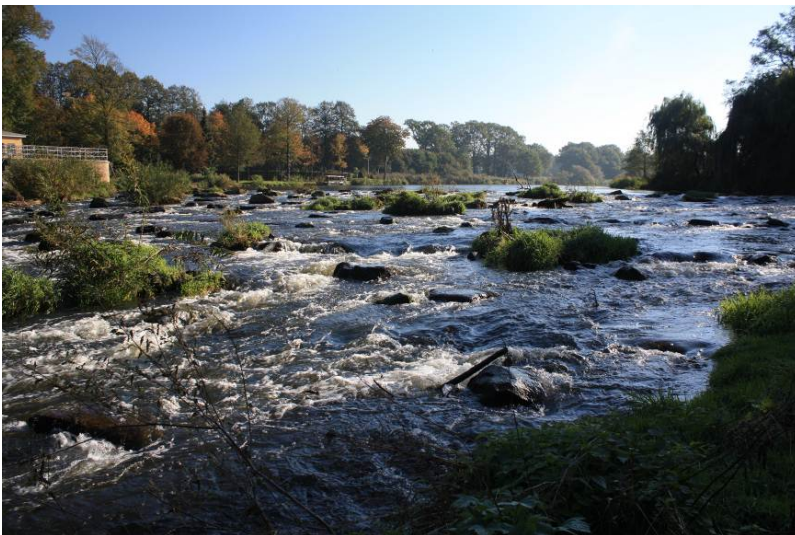
Abb. 36: „Rauhe Rampe“ am Wehr Listrup (Bild: NLWKN Meppen)
