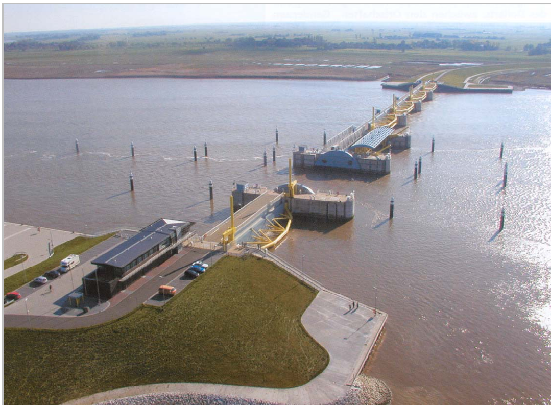
Abb. 45: Blick auf das Ems-Sperwerk bei Gandersum (Foto NLWKN)
