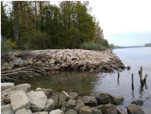
Foto 17: Das rückgebaute Material kann zum Beispiel auch zur Herstellung von Fischunterständen genutzt werden. Hier wurden sie als Ausbuchtung in die Uferlinie gebaut (Foto: STOWASSERPLAN)
