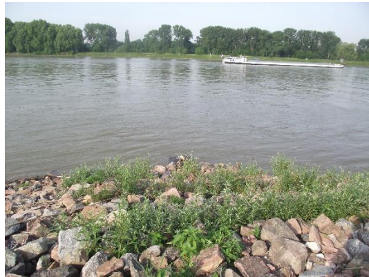
Foto 12: Erster Austrieb der Buschlagen an dieser Bühne (Foto: STOWASSERPLAN)
