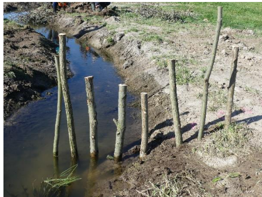
Foto 28: Rechenbuhne, Holzpfähle oder Weidensetzstangen werden als Reihe vom Ufer her bis in das Gewässer reichend quer zur Fließrichtung eingebaut. Derartige seitlich eingebaute Buhnen tragen zur Strömungsberuhigung in den Buhnenfeldern bei. Zwischen den Buhnen bilden sich Anlandungen. (Foto: STOWASSERPLAN)
