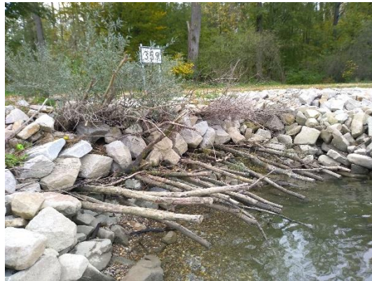
Foto 18: In der Bucht entsteht eine strömungsberuhigte Zone. Das Stangenholz und die Begrünung durch die Buschlage sorgen zunehmend für Beschattung. Detailaufnahme zum Fischunterstand (Foto: STOWASSERPLAN)
