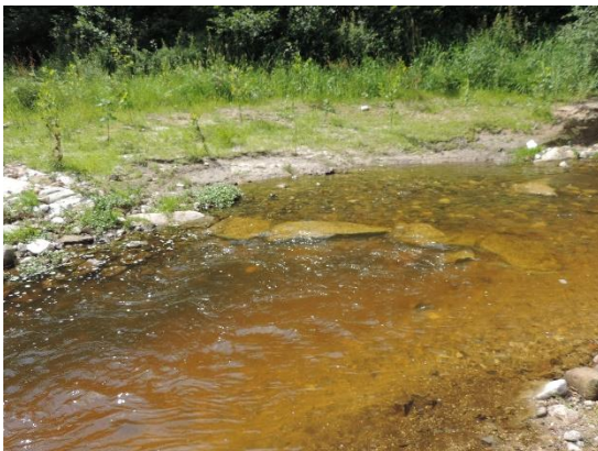
Foto 3: Instreambauweisen, wie diese Hakenbuhne sorgen für eine Strömungsdifferenzierung innerhalb der Sohle. (Foto: STOWASSERPLAN)
