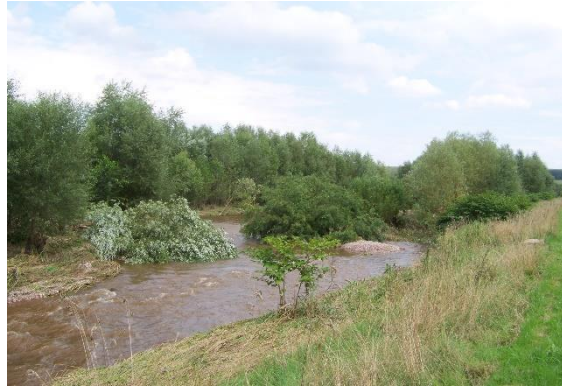
Foto 26: Anschließend wurden ingenieurbiotische Bauweisen zur Steuerung der Eigendynamik und zur Entwicklung von Gehölzen eingebaut. Bereits nach wenigen Jahren haben sich ein dichter Ufergehölzbestand sowie unzählige hochwertige Sohlen- und Uferstrukturen gebildet. (Foto: STOWASSERPLAN)
