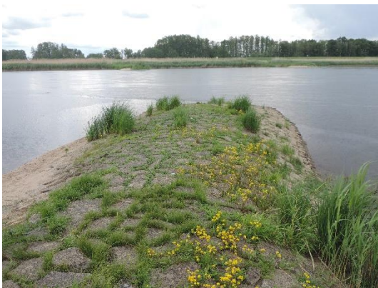
Foto 8: Zur Regulierung der Schifffahrt eingebaute senkrechte Bühne, ausgeführt als unbegrünter Steinsatz (Foto: STOWASSERPLAN)
