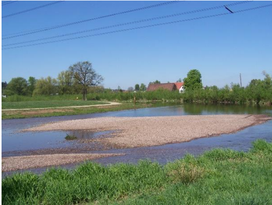
Foto 7: Das Geschiebemanagement sollte innerhalb des gleichen Gewässers erfolgen. Hier wurde vor der Ortslage ein Geschiebfang errichtet, um gezielt Substrat entnehmen und in der freien Landschaft wieder zugeben zu können. (Foto: STOWASSERPLAN)
