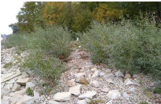
Foto 10: alternative Ufersicherung aus mit Weiden begrünter Steinschüttung am Rhein bei Karlsruhe (Foto: STOWASSERPLAN)
