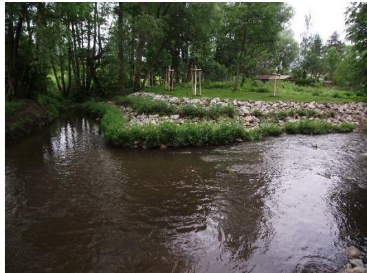
Foto 22: Nach Abschluss der Arbeiten kann sich der Wasserspiegel frei fließend einstellen. Die Begrünung sorgt für Beschattung des Gewässers und die Sicherung der Uferböschungen. (Foto: STOWASSERPLAN)
