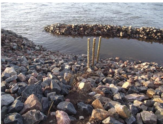
Foto 13: Geschüttetes Längswerk mit Buschlagen und Weidensetzstangen zu sehen. (Foto: STOWASSERPLAN)
