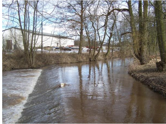
Foto 20: Die Bauwerkshöhe beträgt ca. 0,5 m. Es besteht keine ökologische Durchgängigkeit. (Foto: STOWASSERPLAN)
