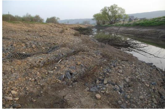
Foto 24: Zur Ufersicherung und Uferstrukturierung können ingenieurbio-logische Bauweisen zum Einsatz kommen. (Foto: STOWASSERPLAN)
