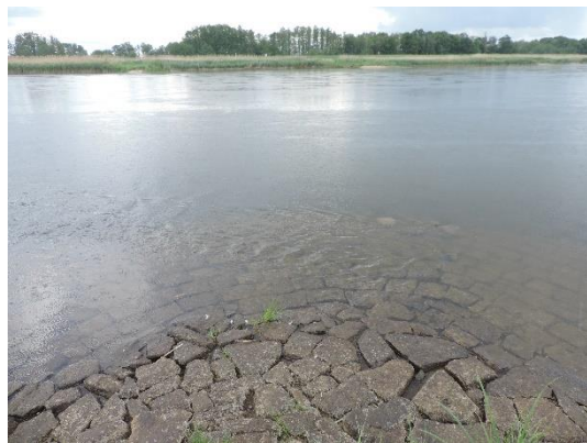
Foto 9: In die Strömung eintauchender Bühnenkopf (Foto: STOWASSERPLAN)
