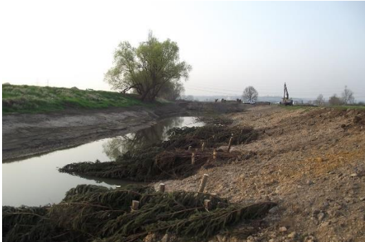
Foto 29: Raubaum, ganze Kronen oder Kronenteile von Laub- oder Nadelgehölzen, die mit der Krone flussabwärts orientiert und in die Fließrichtung geneigt am Ufer befestigt werden. Die Bauweise drückt die Strömung vom Ufer weg und provoziert Erosionen am gegenüberliegenden Ufer. Im Strömungsschatten des Raubaumes bilden sich Flachwasserbereiche und Anlandungen. (Foto: STOWASSERPLAN)
