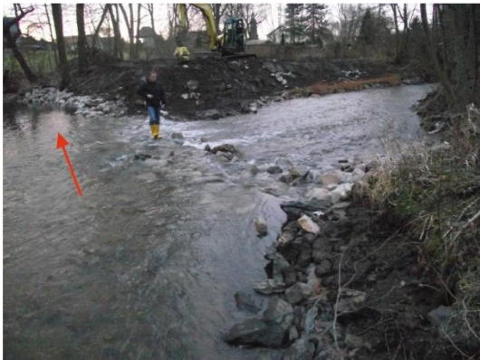
Foto 21: Das Wehr wurde vollständig zurückgebaut. Ufersicherungen erfolgten als mit Weiden begrünte Steinschüttung. (Foto: STOWASSERPLAN)
