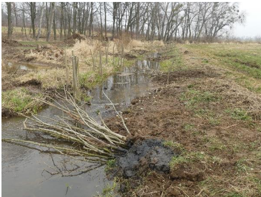
Foto 27: Lebender Abweiser, quer zur Fließrichtung eingebaute, austriebsfähige Äste, die sich zu einem dichten Weidengebüsch entwickeln. Die in den Stromstrich reichenden Äste bewirken Verwirbelungen mit Kolkbildungen sowie Strömungsberuhigungen im Randbereich. (Foto: STOWASSERPLAN)
