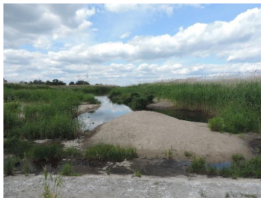
Foto 6: Substratzugaben sollten als Depotschüttung auf dem Ufer erfolgen, so dass sich das Gewässer die Substrate nach und nach mitnehmen kann. (Foto: STOWASSERPLAN)
