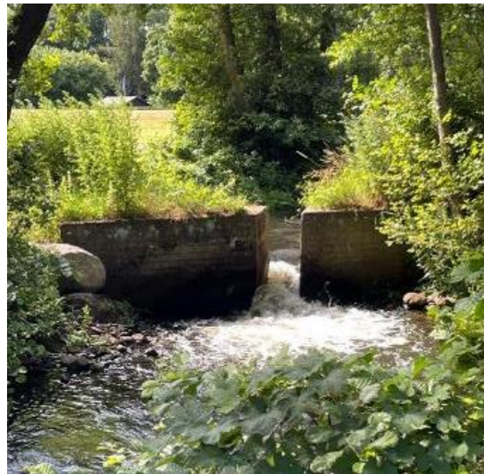
Fischpass am Seeve-Wehr
