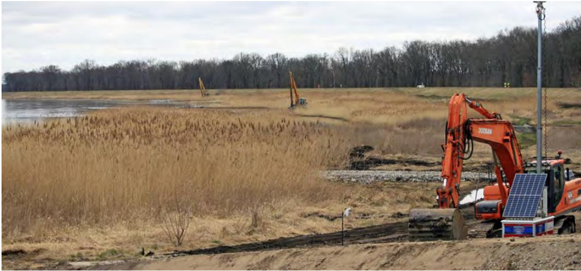
Abbildung 30: Bühnenausbau am polnischen Ufer der Oder bei Górzycza (Foto: Sascha Maier, BUND)
