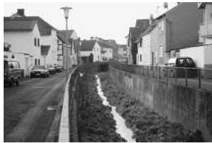
Abb. 2: Der Steinbach (ein Nebengewässer der Swist) in Odendorf, Kastenprofil mit Massivsohle
