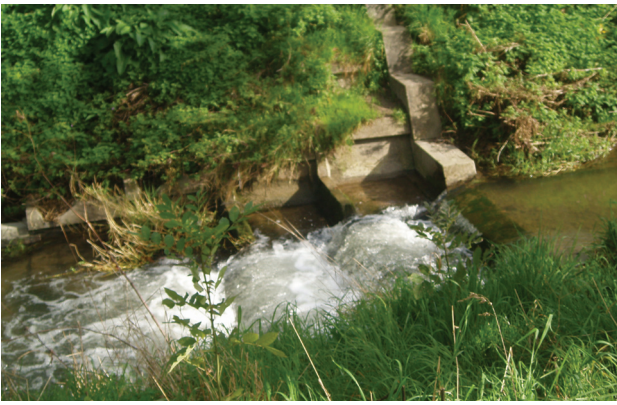
Sohlabsturz am Remtebach - vorher
