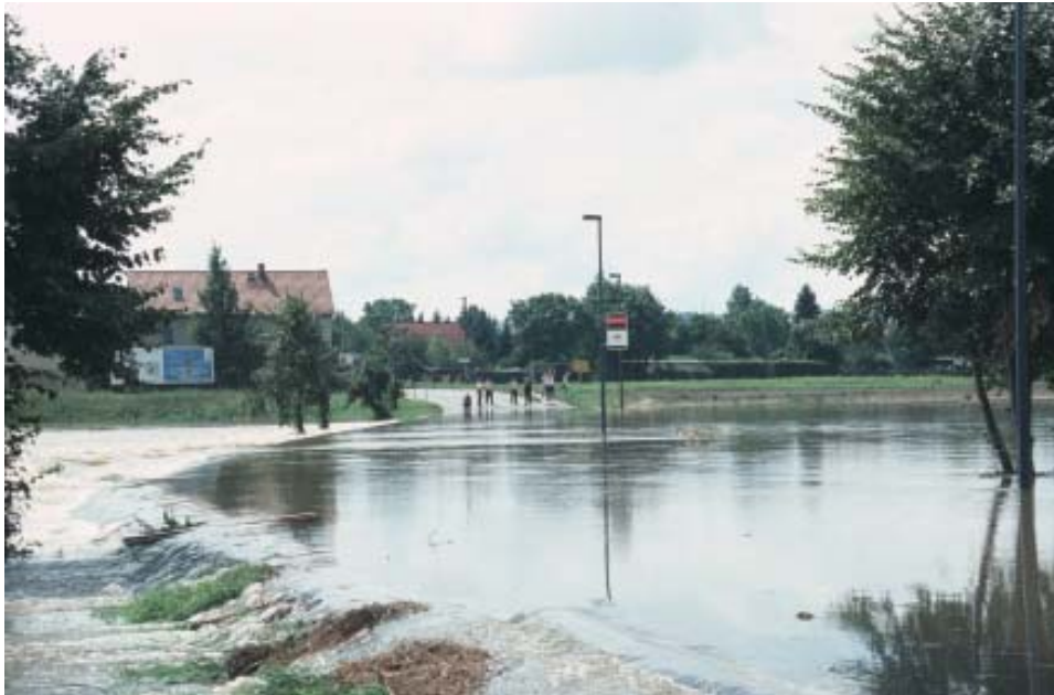
Elbehochwasser 2002: Das Wasser strömt zwischen Dresden und Radebeul in einen alten Flußarm. Umweltverbände fordern seit langem, den Flüssen wo es möglich ist, mehr Raum zu geben. Dadurch könnten besiedelte Regionen besser geschützt werden. Foto: S. Gunkel
