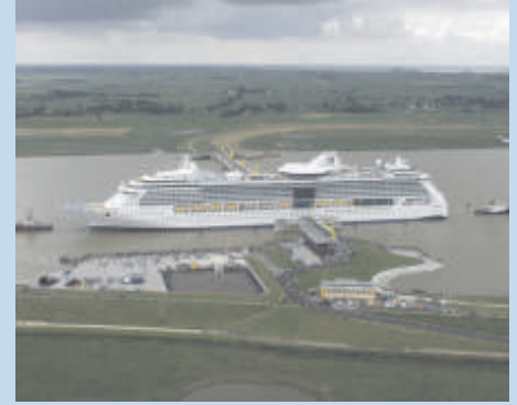
Emssperrwerk bei Gandersum (Foto: NLWKN) Eemsflutung near Gandersum
