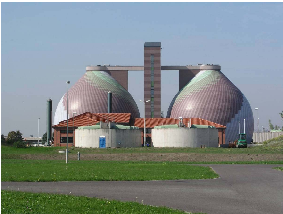
Abb. 7-1: Faultürme der Kläranlage Magdeburg-Gerwisch
