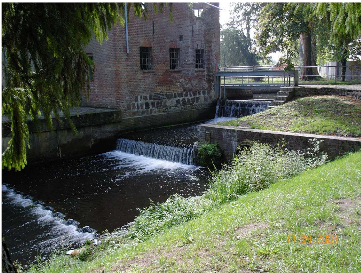
Abb. 4.1.5.4-2: Beispiel für Fischtrepfen in der Milde bei Kalbe
