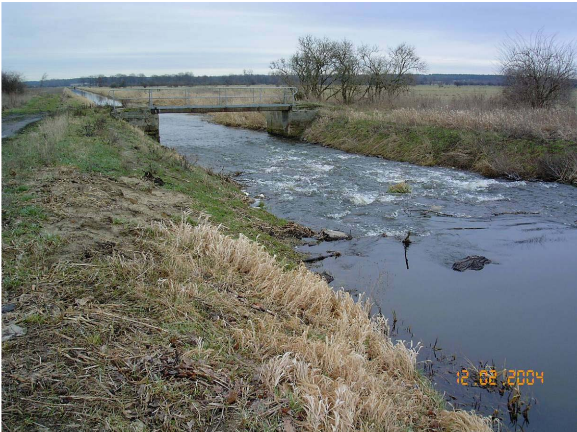
Abb. 6.6-1: Fischgewässer mit Sohlgleiten (Milde-Biese-Aland mit 99,3 km Fließlänge)
