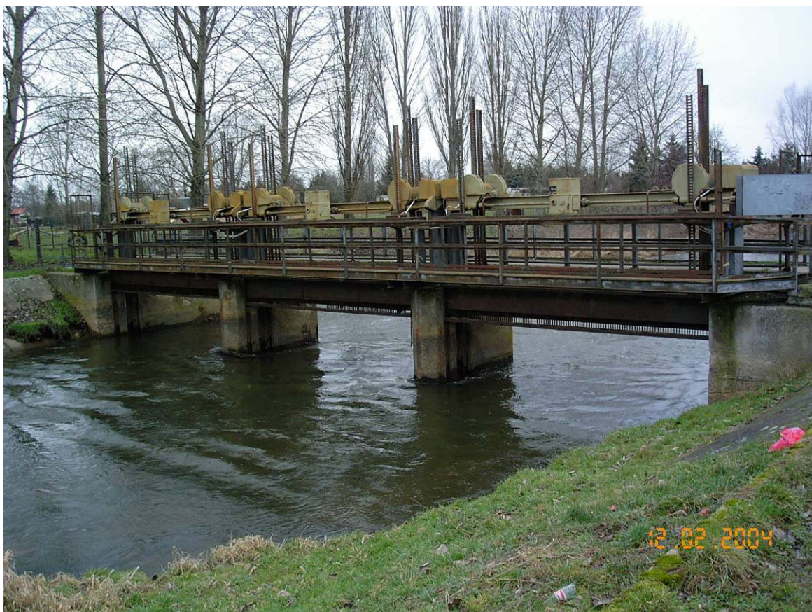
Abb. 4.1.5.4-1: Stauwehr für die Zuckerfabrik Salzwedel
