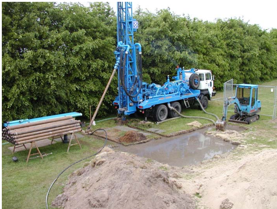
Abb. 6.1-1: Bau von Grundwassermessstellen zur Abgrenzung von Wasserschutzgebieten
