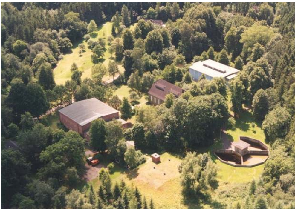
Abb. 4.2.3.3-2: Wasserwerk Schwentinetal der Stadtwerke Kiel AG
