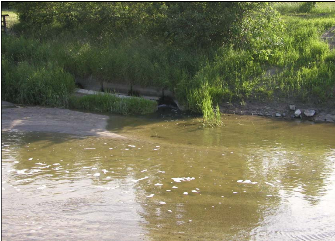
Abb. 33: Fischpass Grafhorst: Einstieg aus dem Unterwasser auf Grund der Auflandung und Versandung (fehlende Anströmung) nicht möglich (Aufstau; 21.05.2006)
