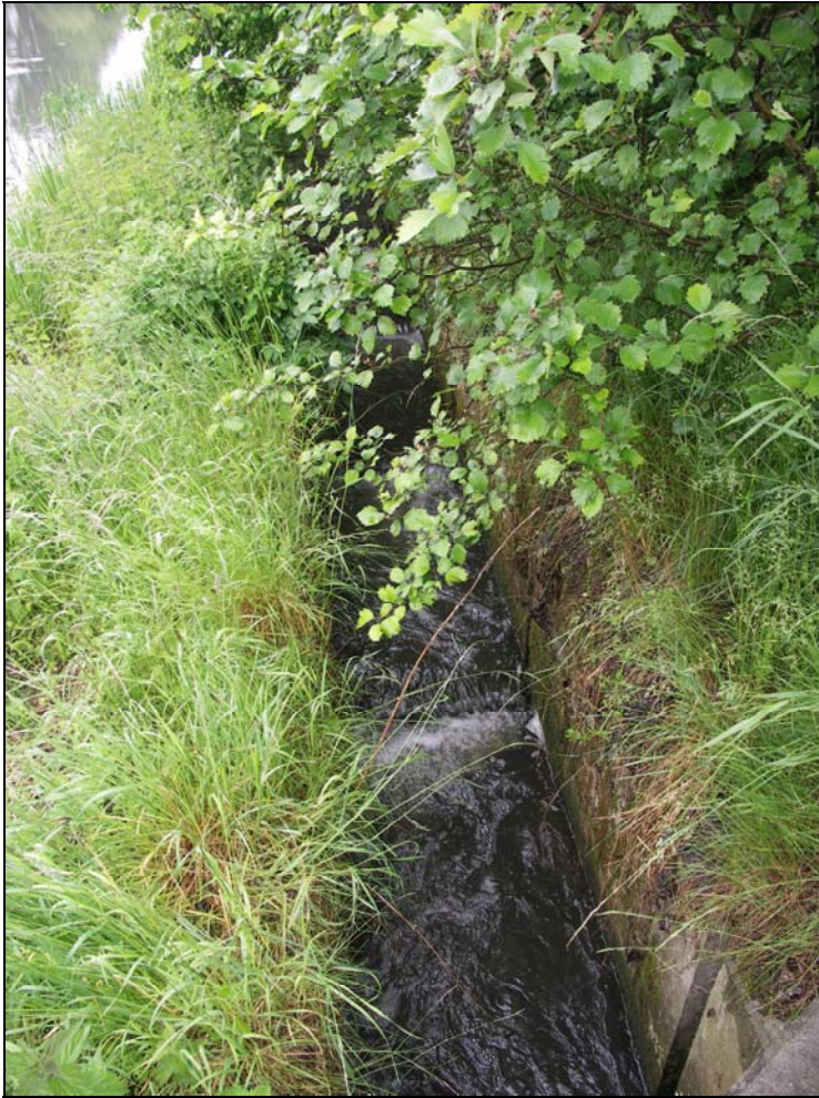
Abb. 37: Fischpass Grafhorst: Hohe Fließgeschwindigkeiten in den Becken bei Aufstau (03.06.2006)
