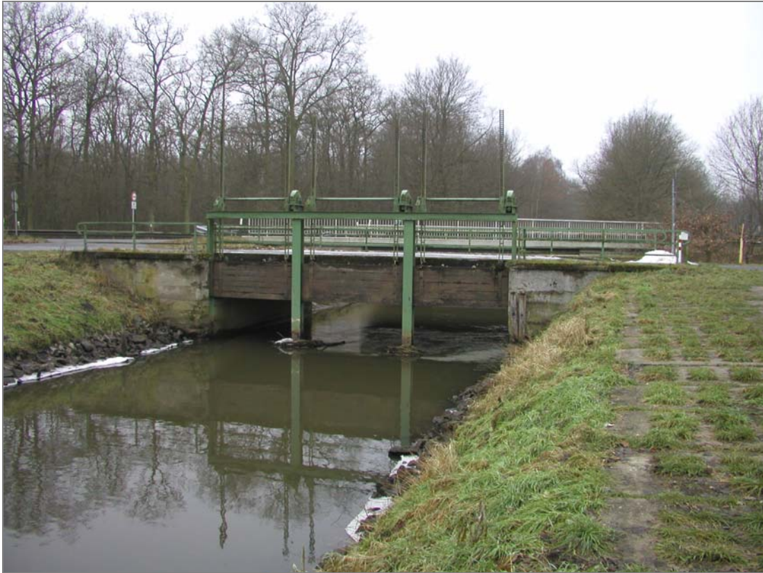
Abb. 15: Das Wehr Weyhäuser Weg im gelegten Zustand während des Winterhalbjahres 2005/06 (Oberwasser; 13.01.2006)
