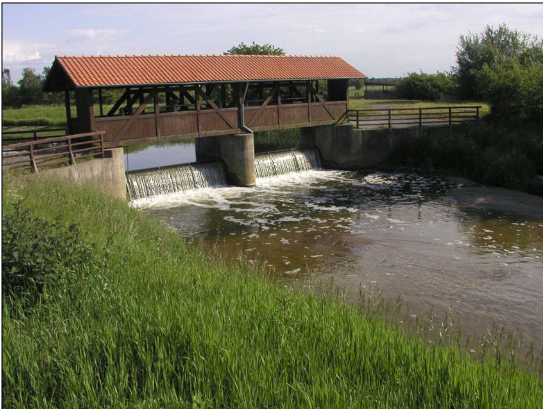
Abb. 26: Das Wehr Grafhorst im gesetzten Zustand im Frühjahr 2006 (Blick von Unterwasser; 07.06.2006)
