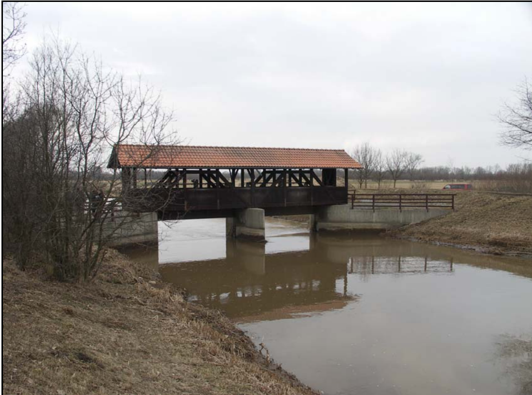
Abb. 25: Das Wehr Grafhorst im gelegten Zustand im Frühjahr 2006 (Blick von Oberwasser; 23.02.2006)
