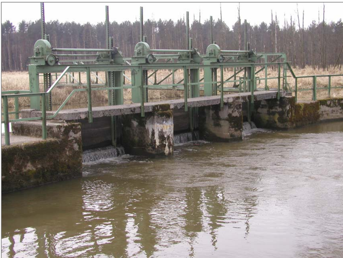
Abb. 16: Das Wehr Weyhausen im teilweise gesetzten Zustand im Februar 2006 (Unterwasser; 23.02.2006)
