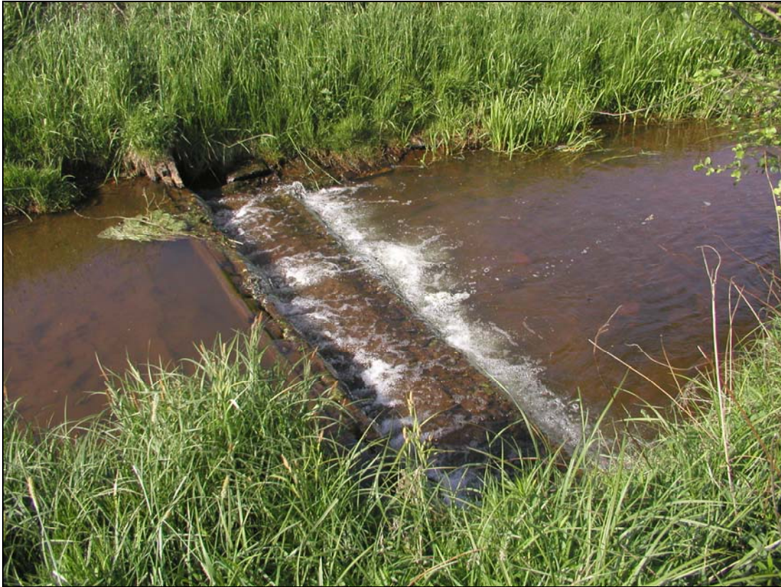
Abb. 39: Im Beverbach stromaufwärts der B 188 befinden sich zwei Kaskadenbauwerke, deren Gesamthöhe > 0,3 m ist (12.05.2006)
