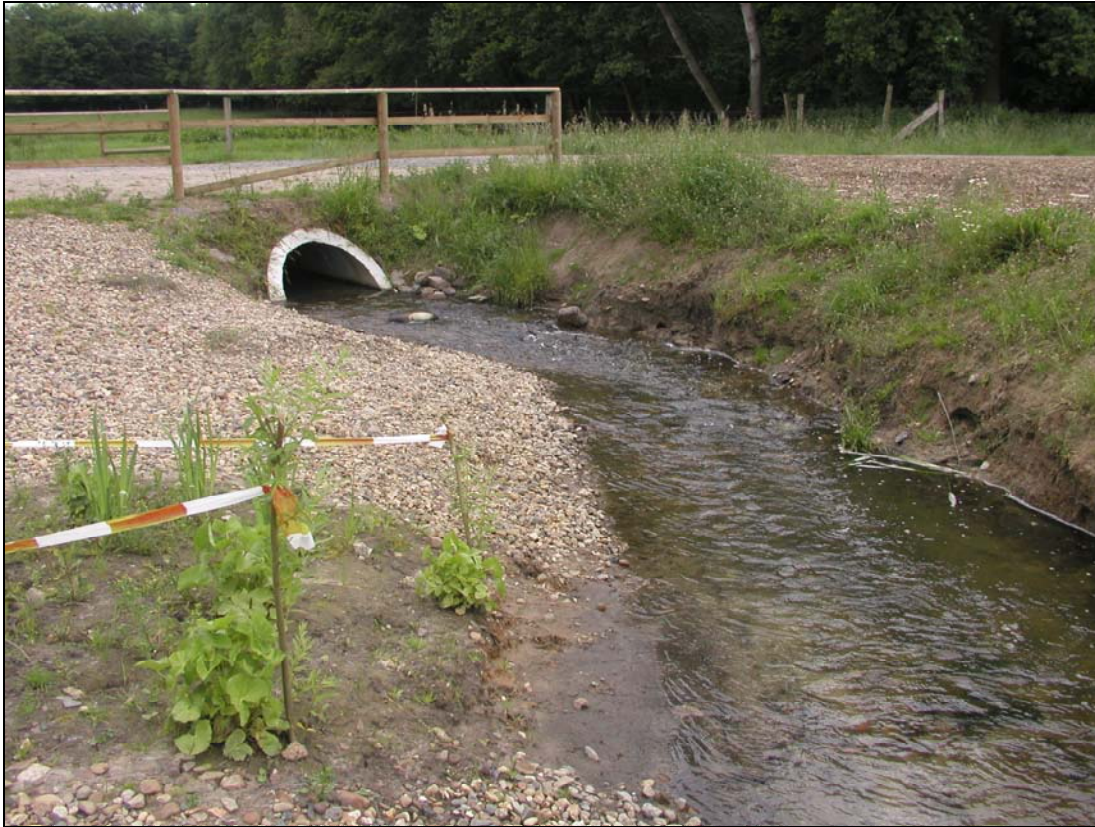
Abb. 41: Positives Beispiel eines Rohrdurchlasses an der Mühlenriede zwischen Ehmern und Mörse (07.06.2006)
