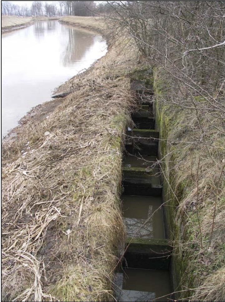
Abb. 31: Beckenfischpass am Wehr Grafhorst bei Niedrigwasser nahezu trockengefallen (21.03.2006)
