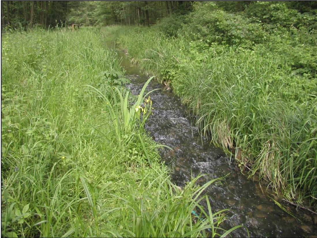
Abb. 40: Ersatz von zwei signifikanten Bauwerken durch eine raue Sohlgleite in der Mühlenriede stromabwärts des Renaturierungsprojektes zwischen Ehmten und Mörse (07.06.2006)
