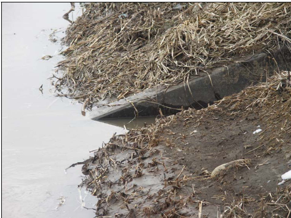
Abb. 35: Fischpass Grafhorst: Einstieg aus dem Oberwasser ohne Anströmung (Niedrigwasser; 21.03.2006)
