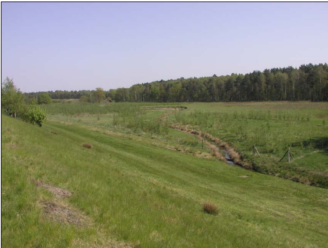
Abb. 38: Renaturierung am Beverbach stromaufwärts der Unterführung des ESK. Der Gewässerverlauf wurde verlegt; drei der in der Querbauwerksdatenbank genannten Bauwerke sind hier nicht mehr vorhanden (12.05.2006)
