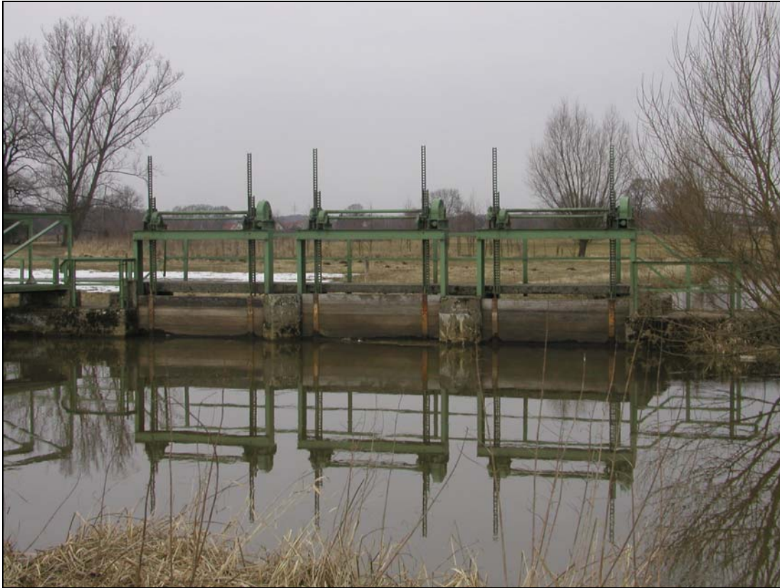
Abb. 17: Das Wehr Weyhausen im gesetzten Zustand im Februar 2006 (Oberwasser; 23.02.2006)
