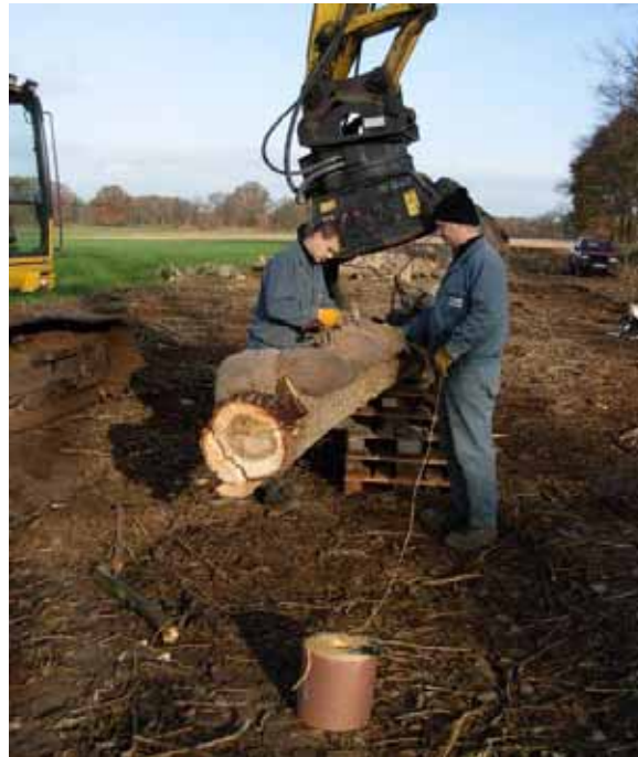
Abb. 5: Befestigung der kiesgefüllten Jutesäcke an einem Stamm
