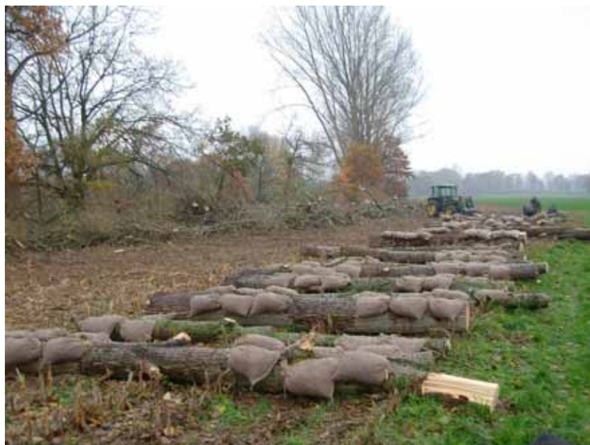
Abb. 8: Gesamtmenge der Pappelstämme der Projektphase 2008 vor Einbau
