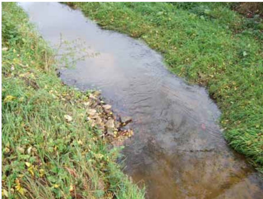
Abb. 43: diagonale Kiesschwelle als Strömungslenker mit sich entwickelndem Krümmungskolk rechts u. Sedimentationsbereich an projektierte Gleithangseite links im Bild, Herbst 2008
