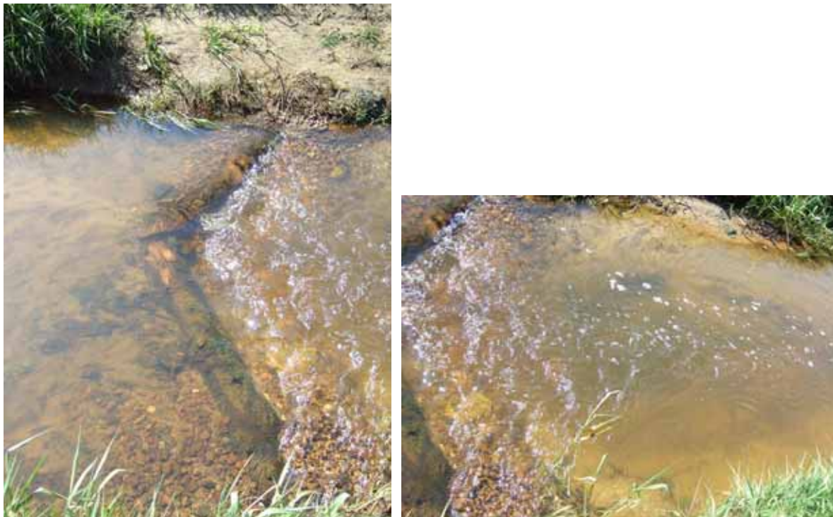
Abb. 53 u. Abb. 54: Dachförmige Totholzschwelle: Einbau auf Kiesschüttung mit Kolk unterhalb, April 2008
