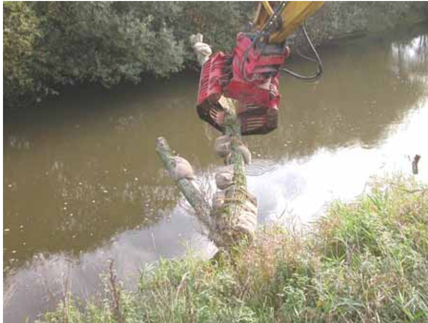
Abb. 6: Einbringen eines beschwerten Tothholzelements
