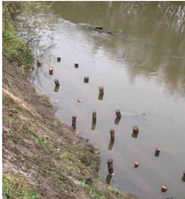
Abb. 7: Vorübergehende Fixierung der größeren Stämme am Böschungsfuß mit Pflöcken
