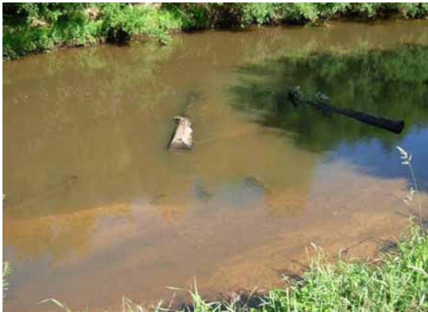
Abb. 9: Totholzgruppierung 2 Jahre nach Einbau mit stark übersandeten Stämmen im Vordergrund
