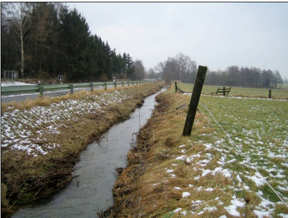
Abbildung 7-12: Begradigter, strukturarmer Hamelabschnitt entlang der K 72 (etwa 200 Meter unterhalb der Mündung der Voßbeeke) (GEUM.tec 2006)
