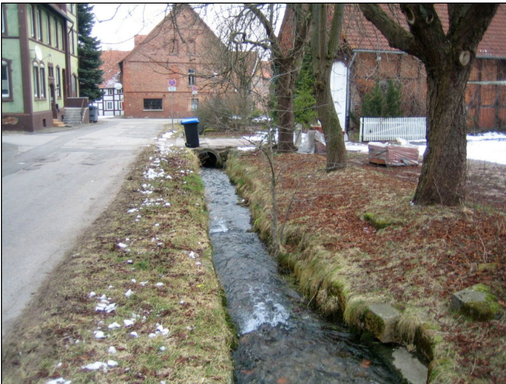
Abbildung 7-11: Ausgebauter Hamelabschnitt entlang der Straße „Zur Hamelquelle“ in Hamelspringe (GEUM.tec 2006)
