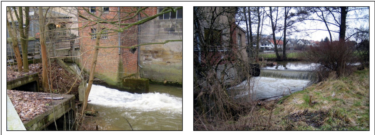
Abbildung 7-24: Wehre an der Mühle „Zur Lust“ in Rohrsen (GEUM.tec 2006)
