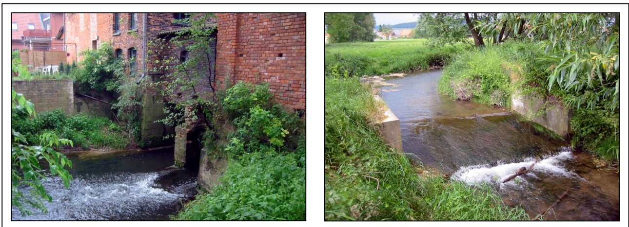
Abbildung 7-21: Wehranlage der Mühle in Hachmühlen (links) und Sohlgleite im Hauptgerinne (rechts) (GEUM.tec 2006)
