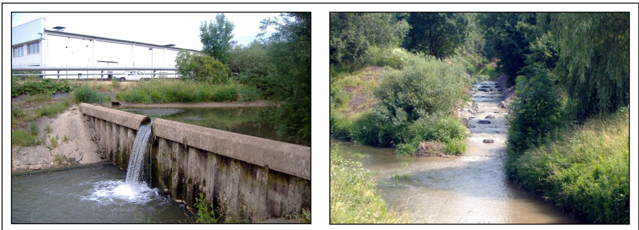
Abbildung 7-25: Marienthaler Wehr (links) und das neu erstellte Umgehungsgerinne (rechts) (GEUM.tec 2006)
