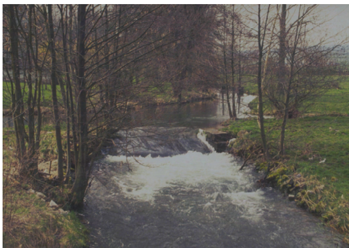
Foto 29: Ableitungswehr zur Körberschen Mühle, Dassel
