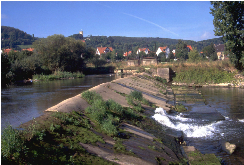
Foto 8: Leine bei Greene. Durch eine 1921 erbaute Wehranlage wird das Wasser in den Betriebsgraben Richtung Kraftwerk gelenkt
