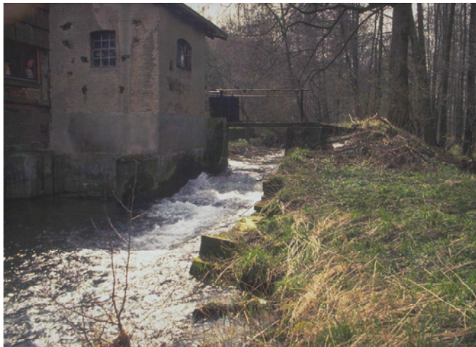
Foto 28: Wehranlage Dassel, oberhalb Zufluss Spüligbach
