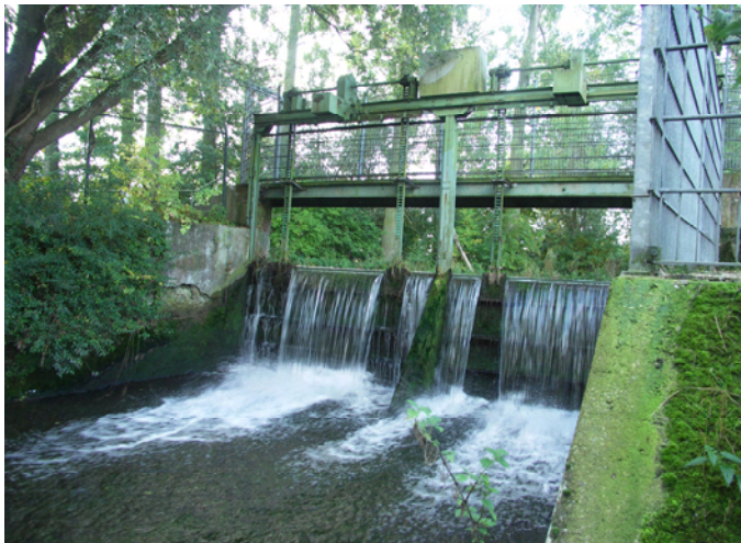
Foto 39: Wehranlage im Bereich der Stegemühle, Stadt Göttingen
