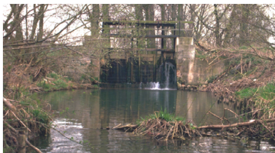
Foto 22: Die Wehranlage Gartemühle ist eine Barriere für alle Wasserorganismen. Die Durchgängigkeit wurde 2004 durch ein Umgehungs-gewässer wiederhergestellt
