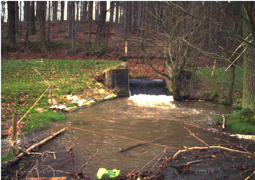
Foto 1: Garte. Wehr mit Betonrutsche zwischen Rittmarshausen und Wöllmarshausen
