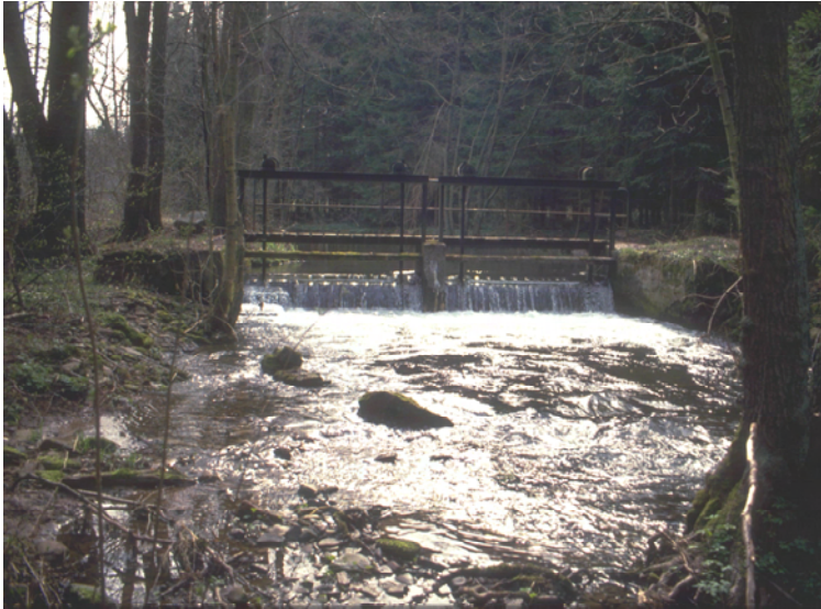
Foto 3: Ilme. Wehranlage mit Absturz oberhalb Relliehausen
