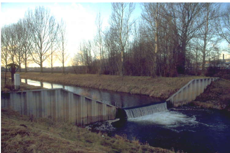
Foto 5: Ilme. Sohlabsturz Einbeck oberhalb der L 487
