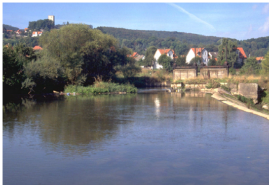
Foto 46: Rückstaubereich der Wehranlage Greene mit nahezu stehenden Wasser
