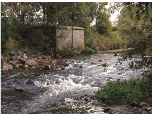
Foto 37: Ehemaliges Wehr bei Obernjesa zu rauer Sohlgleite umgebaut und durchgängig
