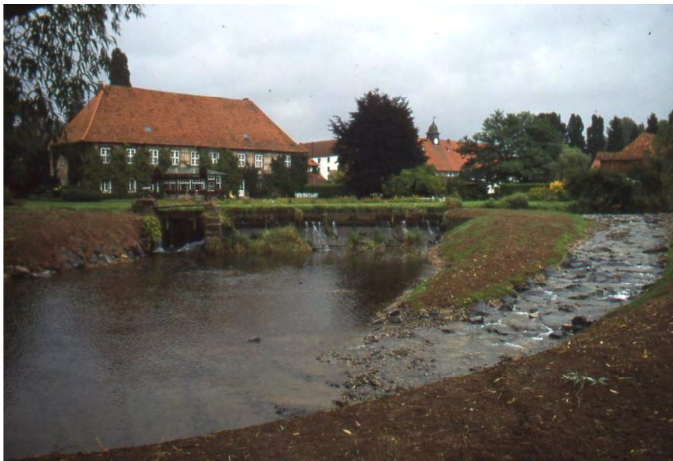
Foto 6: Die Wehranlage der Leine am Gut Besenhausen (LK Göttingen). Bei einer Höhe des Wehrs von etwa 2,5 m wurden alle flussauf- und flussabwärts gerichteten Wanderungen der Wasserfauna unterbunden. Das Wehr wurde 2001 durch ein Umgehungsgewässer durchgängig gemacht
