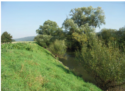
Foto 49: Eingedeichte Leine nördlich Greene mit starker Tiefenerosion
