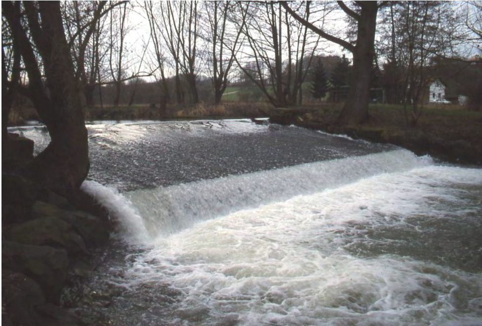
Foto 7: Leinewehr südlich Friedland. Bei einer Absturzhöhe von ca. 2,5 m, einer Betonrutsche von ca. 10 m Länge mit schießendem Wasser ist die Anlage für alle flussaufwärts und weitgehend auch für die flussabwärts gerichteten Wanderbewegungen der Gewässerfauna undurchgängig. 2002 wurde die Durchgängigkeit durch Bau eines Umgehungsgewässers wieder hergestellt
