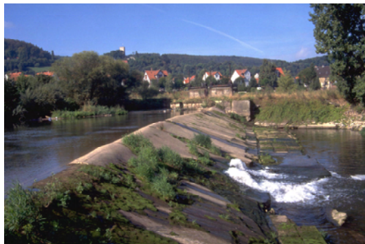
Foto 45: Wehranlage Leine bei Greene, über die nahezu der gesamte Abfluss in ein Wasserkraftwerk geleitet wird
