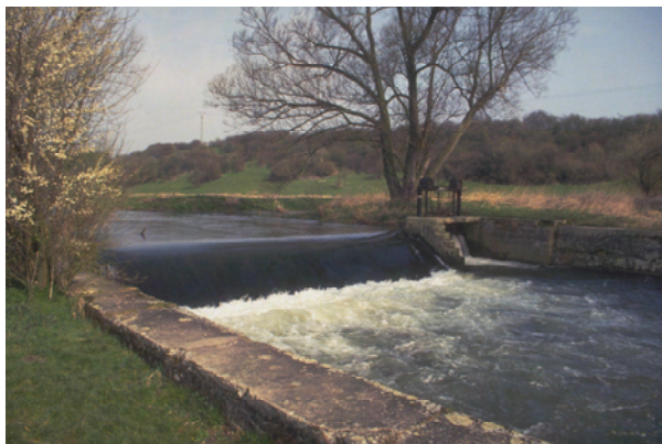
Foto 32: Wehranlage (Ableitung zum Mühlenkanal Einbeck) unterhalb Hullersen
