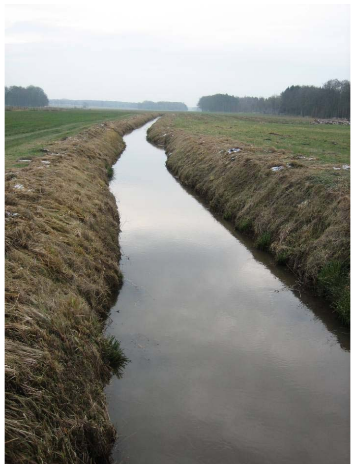
Abbildung 3-2: Wiedau im Einzugsgebiet der Wümme, Sandgeprägter Tieflandbach (Typ 14) naturferner und strukturarmer Abschnitt
