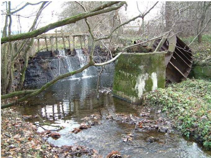
Abbildung 3-4: Ehemaliges Mühlenwehr im Kateminer Mühlenbach, kiesgeprägter Tieflandbach (Typ 16)
