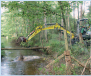
Kieselnbau zur Verbesserung der Gewässerstruktur
