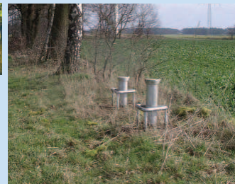
Messstellen für die Grundwasserüberwachung
