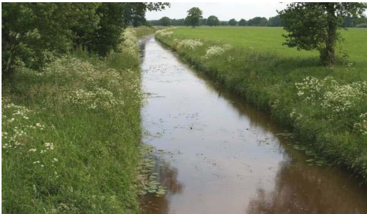
Messstelle 2 im Bereich der Straßenbrücke K35 bei Ahrens-dorf (Blickrichtung stromauf)
