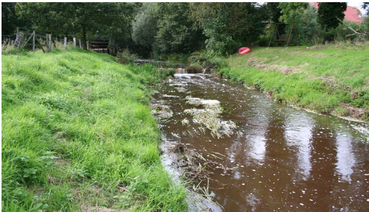
Messstelle 3 im Bereich Giehlermühle / Straßenbrücke B74 (Blickrichtung stromauf)
