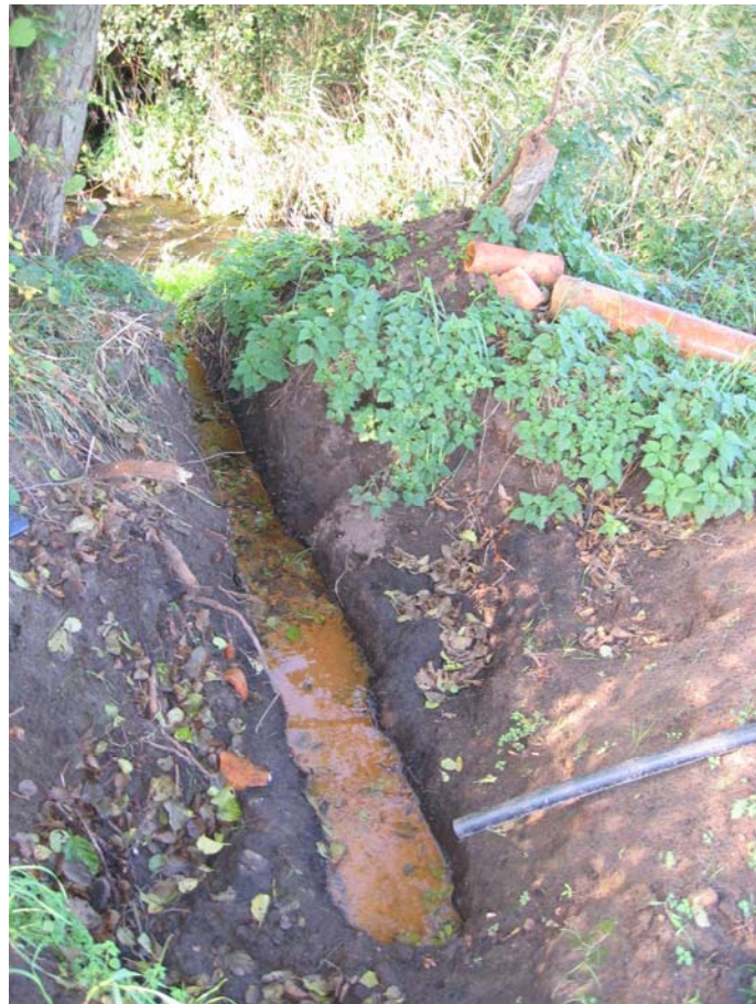
Abbildung 36: Eintritt von Sedimenten aus einer Drainage am Hanstedter Mühlenbach
