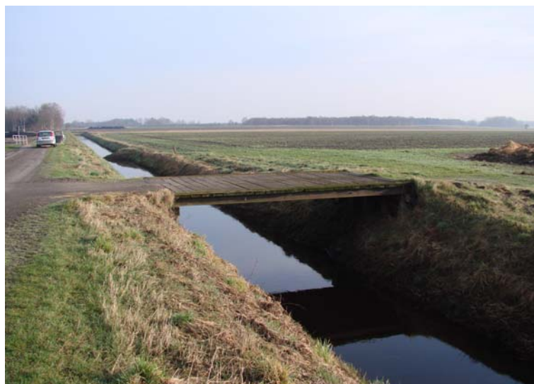
Abbildung 22: Zusammenfluss Schmoor/Reithbach bei km 6+000
