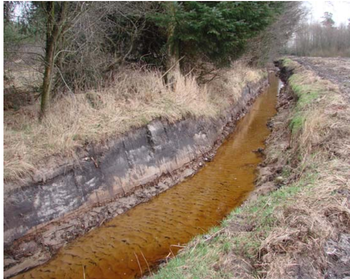
Abbildung 20: Profilerhalt am Reithbach, Blick entgegen Fließrichtung (km 8+500)
