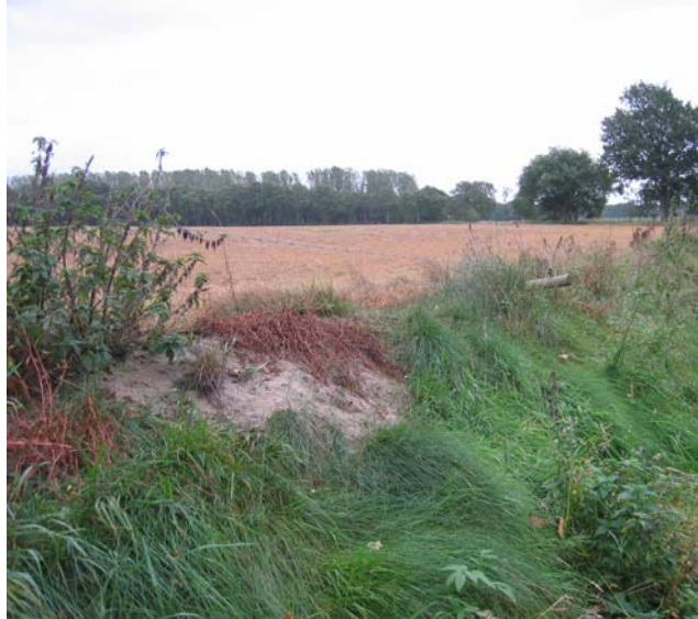
Abbildung 31: Sedimentablagerungen im Uferbereich (km 6+000)
