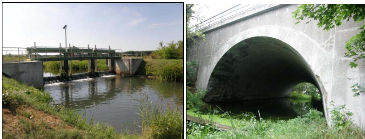
Abbildung 13: Links: ökologisch nicht durchgängiges Wehr Woltersdorf (Nuthe); rechts: in der Stöcker für den Fischotter nicht passierbare Eisenbahnbrücke
