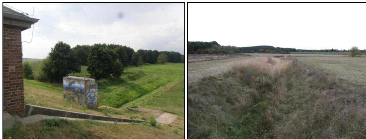
Abbildung 22: Links: Regenrückhaltebecken an der Nuthe oberhalb von Trebbin; rechts: ständig trockener Lauf des Schafrabens nördlich des Seddiner See
