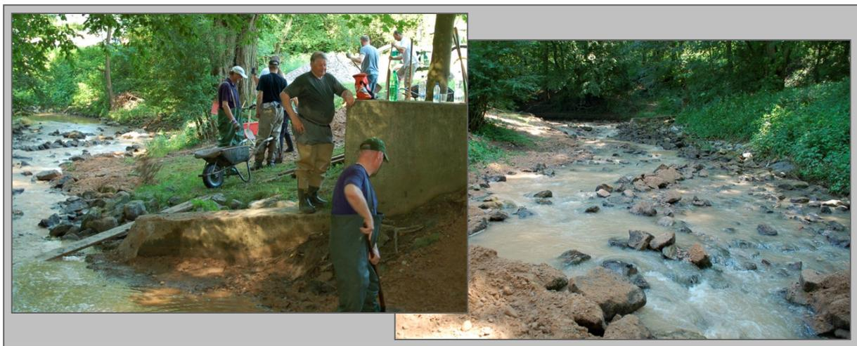
**Abbildung 3:** Freiwillige Helfer beim Anlegen einer Sohlrampe und die fertige Rampe
