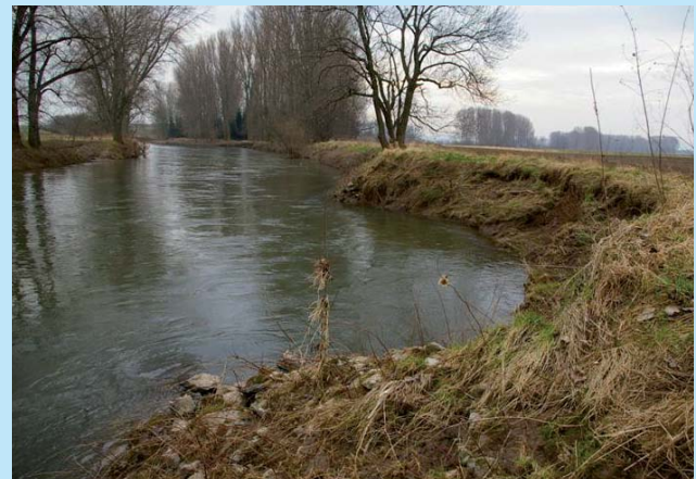
... die Anlieger wollen eigene Aufwendungen zur Ufersicherung vermeiden. (Fotos: Uwe Schmida, Michael Jürging)
